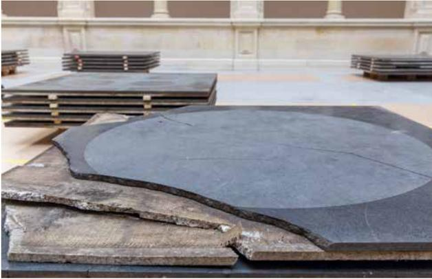
Abb. 3: Beschädigte Granitplatten bei Beginn der Schaurestaurierung, April 2021
